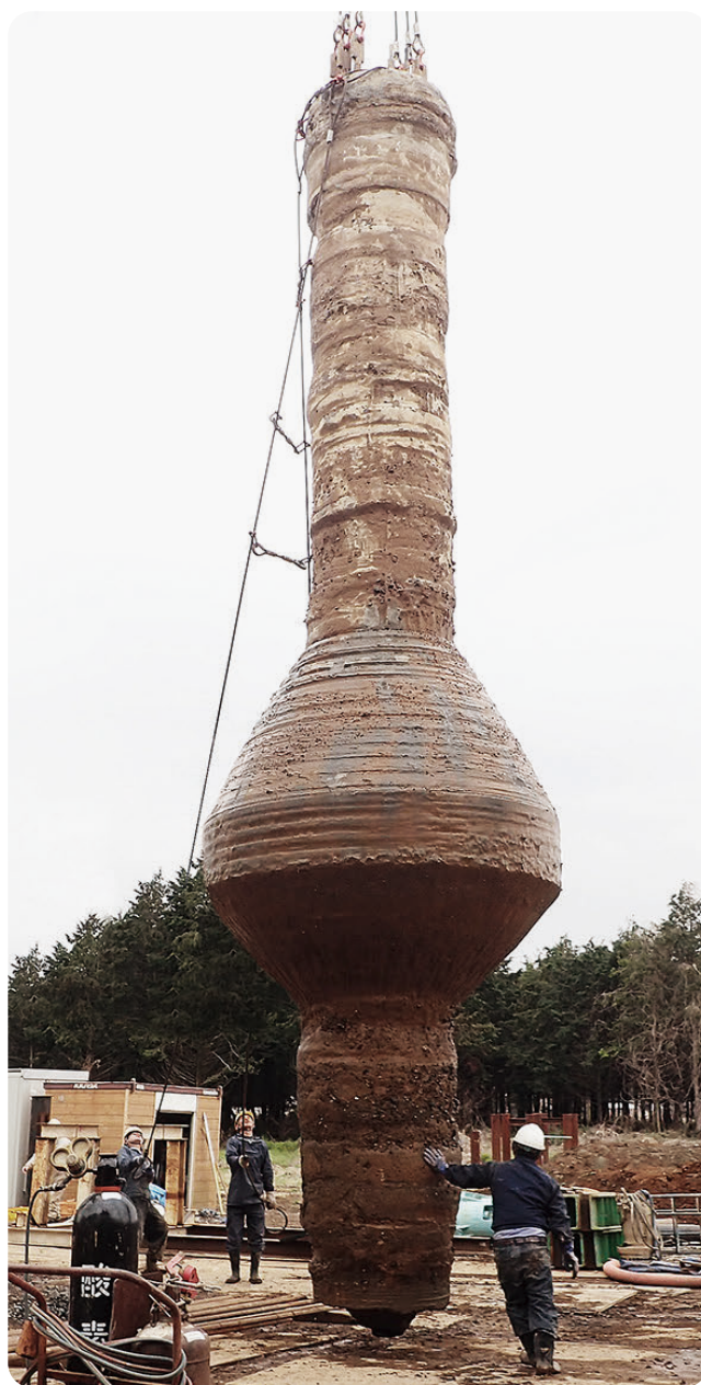
T-EAGLE杭の試験状況
