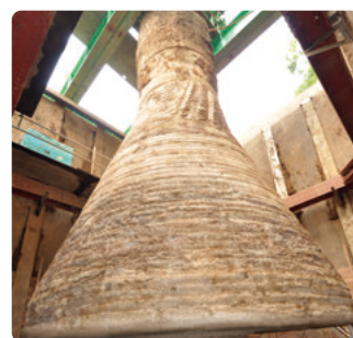
拡底部の掘出し調査
