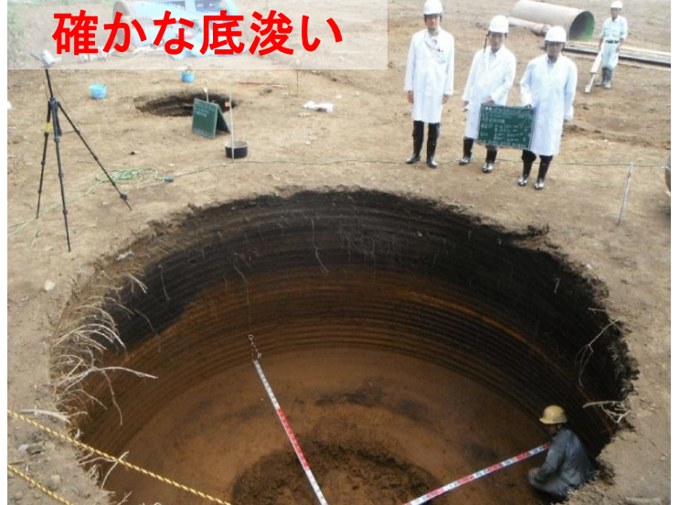
浅層掘削後の状況 φ5500
