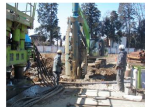
4. 拡底掘削・排土状況
