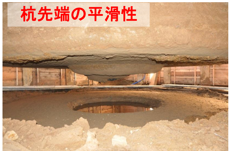
掘出し後の杭先端状況 φ5500
