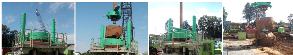
1. 回転治具・反力治具設置
