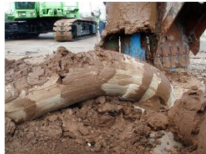
2. 軸部掘削・排土状況
